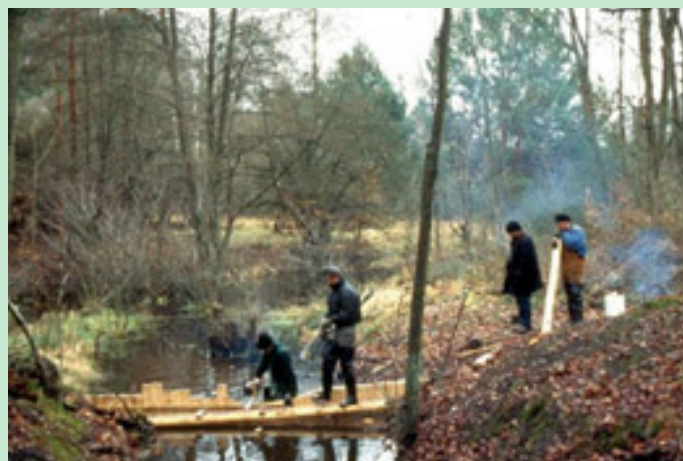
Odtworzone małe zbiorniki wodne (powyżej), budowa zastawki (poniżej).
