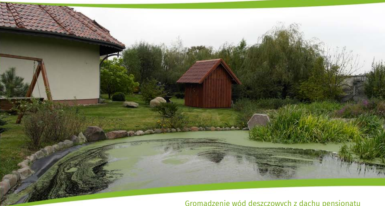
Gromadzenie wód deszczowych z dachu pensjonatu
