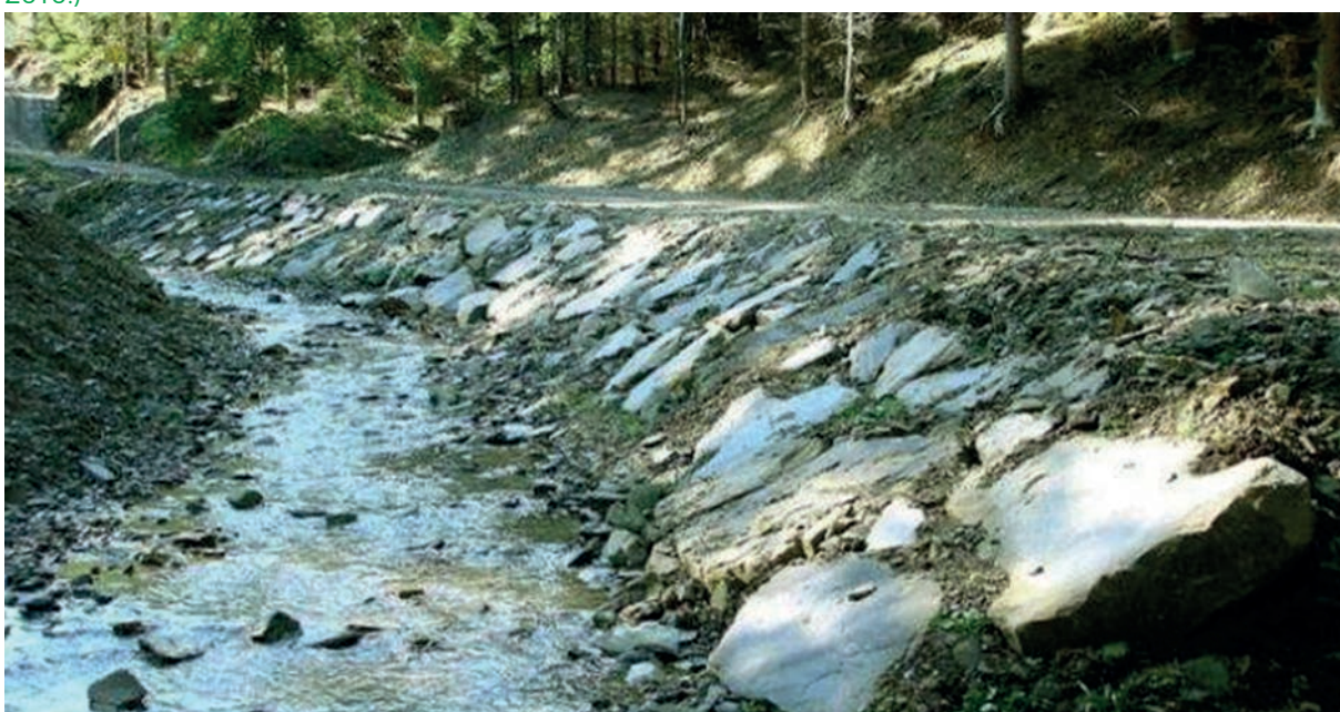
Ryc. 38 Przyjazna naturze renaturalizacja koryt (wg. Dobre praktyki w realizacji obiektów małej retencji w górach. Przeciwdziałanie skutkom odpływu wód opadowych na terenach górskich. Zwiększenie retencji i utrzymanie potoków oraz związanej z nimi infrastruktury w dobrym stanie, 2010.)
