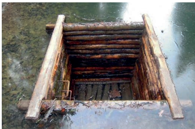
Ryc. 36 Drewniana studnia przelewowa i piętrząca wód wzebraniowych, odtworzony zbiornik zbiorczy w zlewni kilku potoków w Nadleśnictwie Podgórzyn (fot. Ryszard Majewicz)
