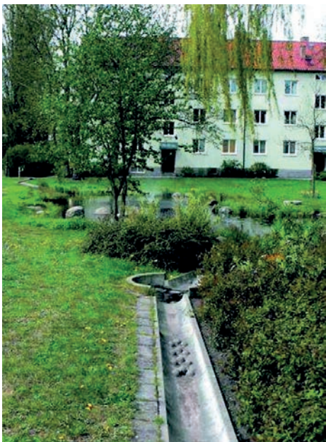
Ryc. 41 System drenażu na osiedlu Augustenborg w Malmö (Szwecja) jest przykładem inicjatywy mającej na celu m.in. odciążenie systemów kanalizacyjnych oraz poprawę bioróżnorodności terenu. W latach 1998–2002 na terenie osiedla powstało wiele zrównoważonych systemów drenażu, w tym rowy chłonne, stawy retencyjne, dachy zielone oraz obszary bioretencji (Burszta-Adamiak, 2012)
