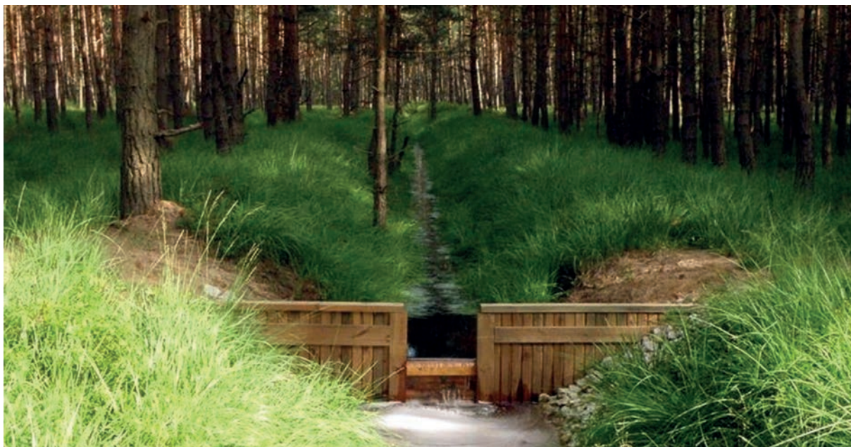
Ryc. 34 Jedna z 50 zastawek zamontowanych na rowie w Nadleśnictwie Ruszów w ramach kompensacji budowy autostrady A4 (fot. Jerzy Dauber)
