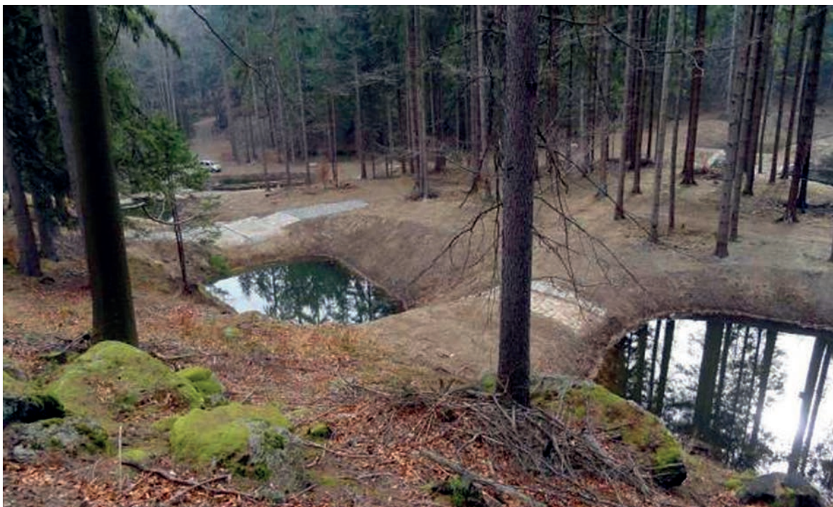
Ryc. 32 Kaskada zbiorników z przelewami górnymi w Nadleśnictwie Śnieżka (fot. Ryszard Majewicz)
