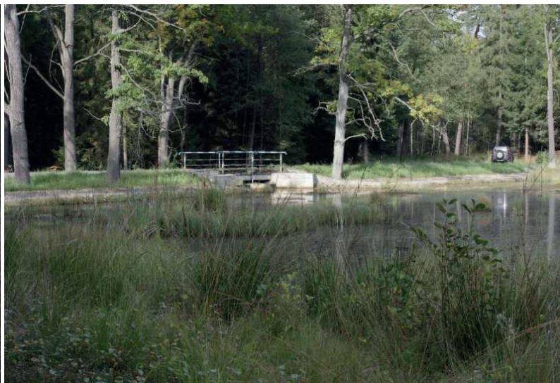
Ryc. 27 Zbiornik retencyjny – miejsce największej ingerencji w teren poprzez umocnienie skarpy drogi i budowę jazu
