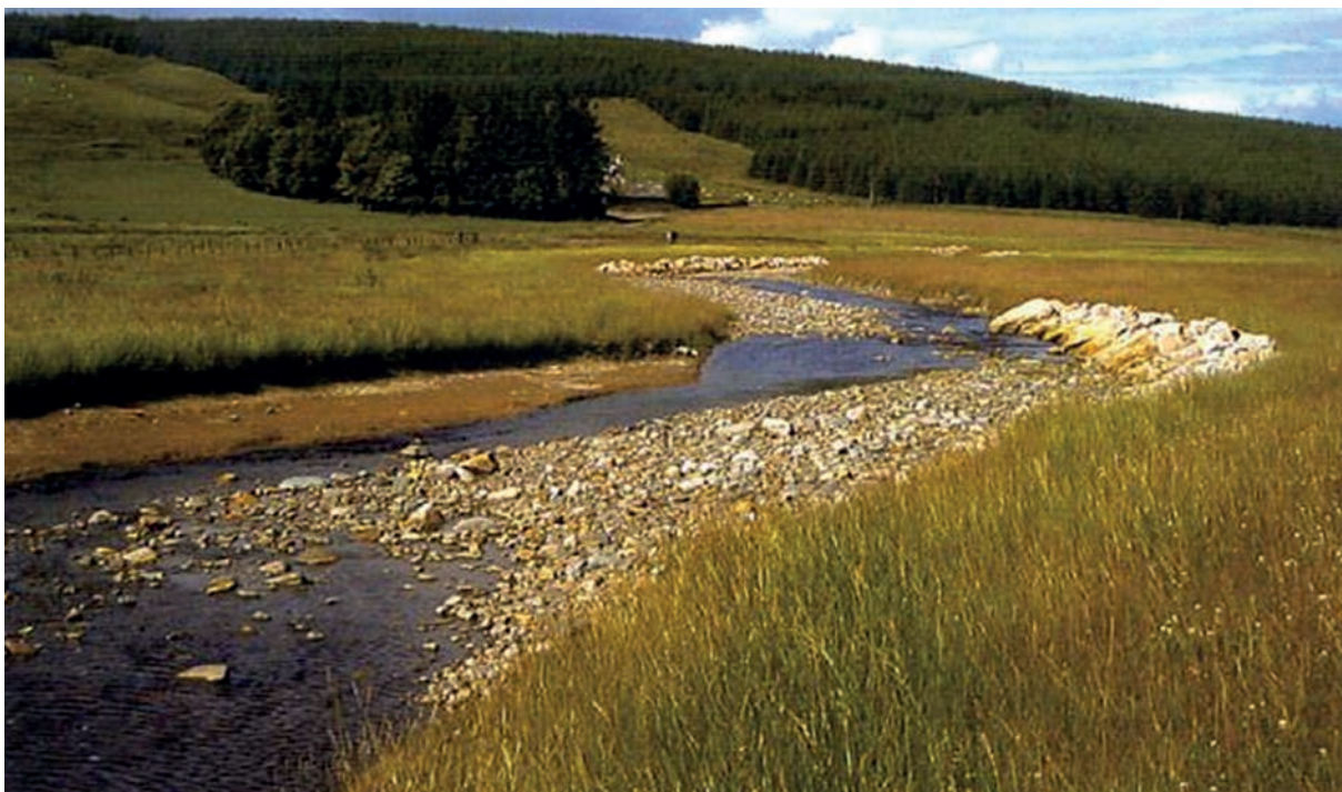
Ryc. 37 Przyjazna naturze renaturalizacja koryt (wg. Dobre praktyki w realizacji obiektów małej retencji w górach. Przeciwdziałanie skutkom odpływu wód opadowych na terenach górskich. Zwiększenie retencji i utrzymanie potoków oraz związanej z nimi infrastruktury w dobrym stanie, 2010.)
