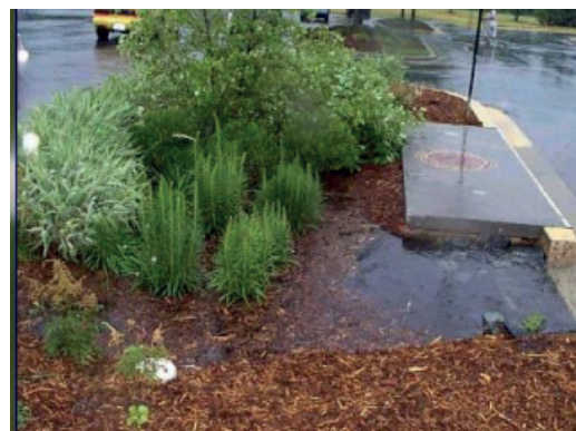
Ryc. 45 Ogród deszczowy jako element kanalizacji burzowej w mieście 28 .
